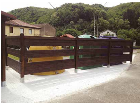
GUARDACONTENEDOR DE RESIDUOS URBANOS
